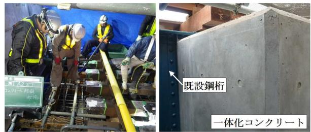
写真-4 速硬性コンクリートの打込み状況(左)および出来栄(右)
