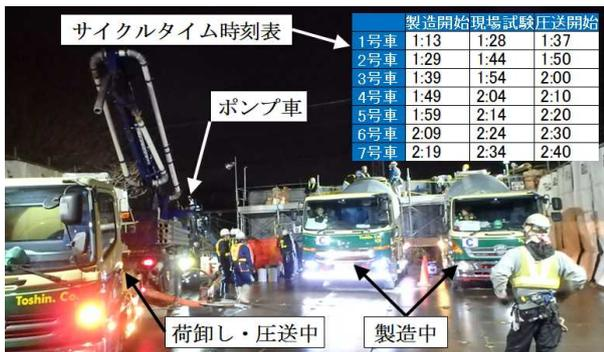
写真-3 速硬性コンクリート製造・圧送状況
