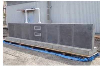
写真-9 実物大試験体完成
