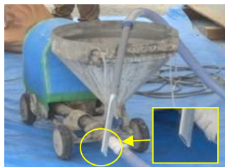
写真-3 モルタル充填器具
