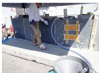
写真-2 事前確認試験状況
