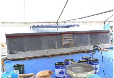
写真－6 UFC パネル組立完了
