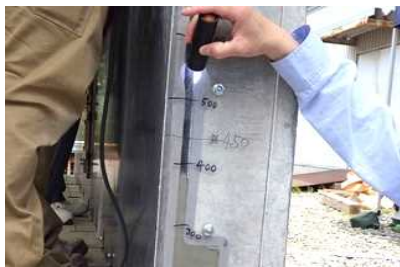
写真-7 透明型枠による充填確認
