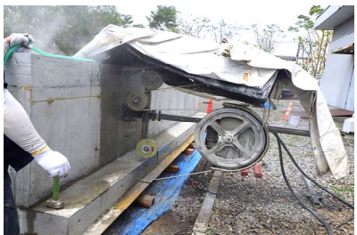
写真-10 ワイヤソーによる切断
