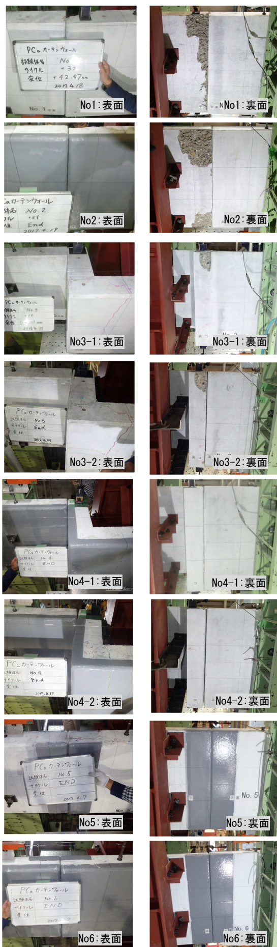
写真-1 実験終了時における各試験体の損傷状況
