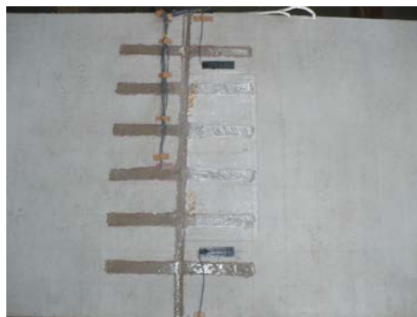
写真-2 かすがい継ぎ手の試験後の状況
