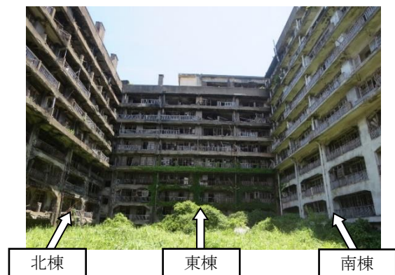
図-3 65 号棟北西側の外観
