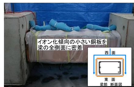
写真-1 電食の様子
