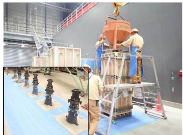
写真-2 打設状況と静置スランプ試験 (左下)
