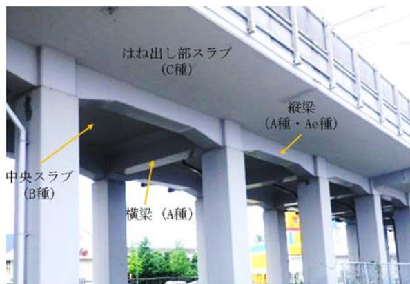
図-1 新幹線高架橋における既設表面保護工<sup>1)</sup>
