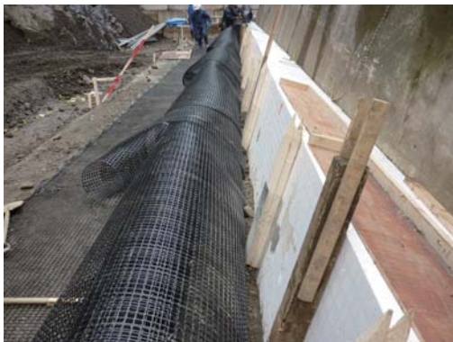
(b) ジオグリッド設置状況 8)
