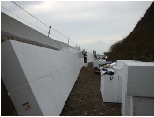
(a) EPS ブロック設置状況 7)
