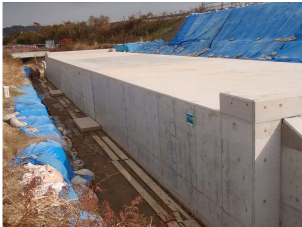
写真-8 対象構造物の全景 (手前から1, 2, 3ブロックの順)
