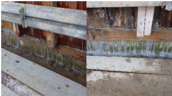
写真-6 各スランプの型枠末端部の様子 （左：スランプ8cm，右：スランプ12cm）
