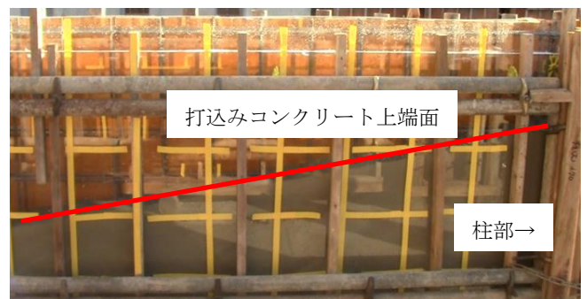
写真-4 模擬部材打込み状況（流動化コンクリート）
