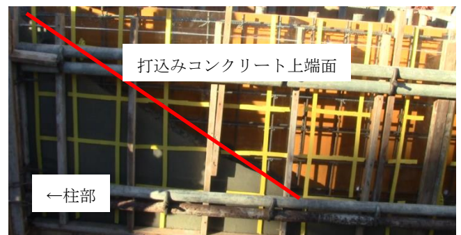
写真-3 模擬部材打込み状況（ベースコンクリート）
