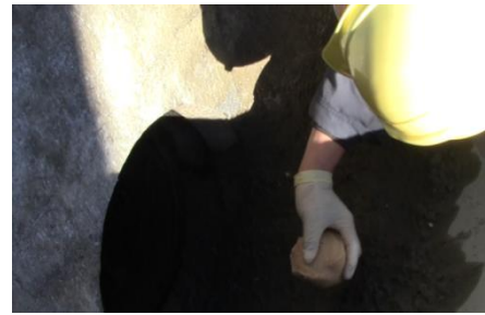
写真-2 流動化剤投入状況
