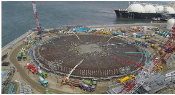
写真-2 コンクリート施工状況
