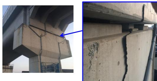
写真-1 実桁に生じたせん断ひび割れ
