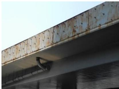
図-1 補強鋼板の腐食状況例
