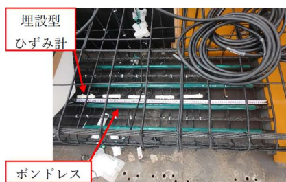
写真-2 ボンドコントロール及び埋設型ひずみ計配置
