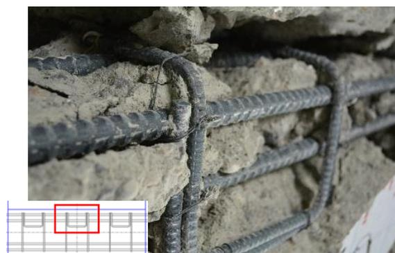
図-6 キャップタイ定着部のひび割れ
