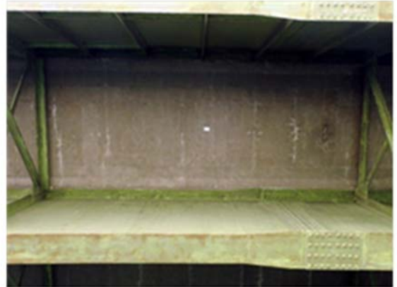
写真-3 床版下面
