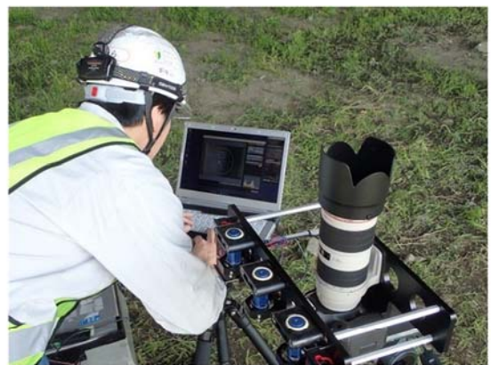
写真-4 計測状況
