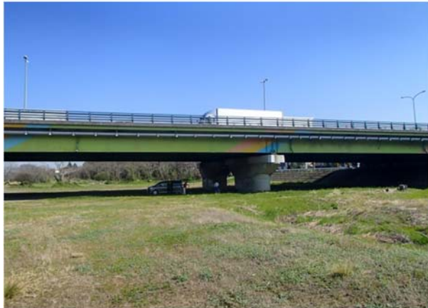
写真－2 計測対象の橋梁
