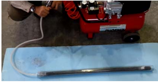
写真-2 気化性防錆剤圧入の様子（先入れ）
