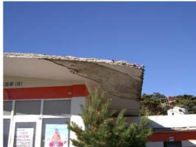
写真-5 軒先の剥落と鉄筋露出
