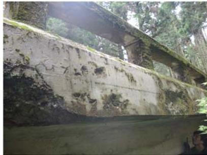
写真-4 橋梁の桁に生じたポップアウト
