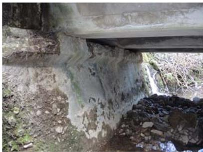
写真-7 橋台に生じたスケーリング
