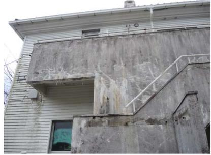
写真-3 階段側面に生じたエフロレッセンス
