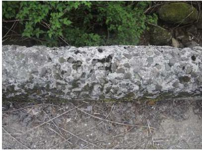
写真-1 橋梁の地覆に生じたスケーリング
