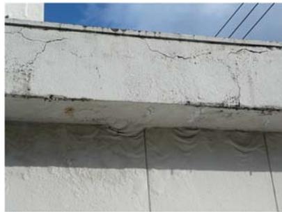
写真-8 建物に生じたひび割れと防水層の膨れ
