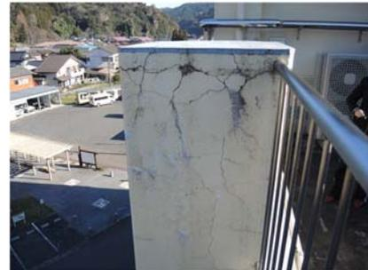
写真-6 独立柱の頂部に生じたひび割れ
