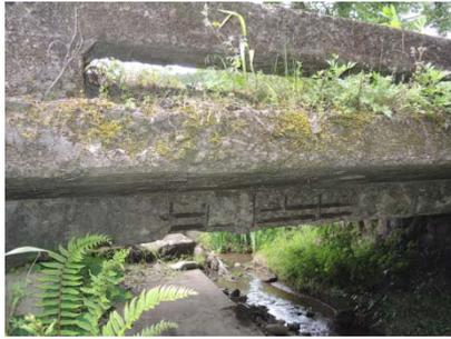
写真-2 桁に生じたスケーリングと鉄筋露出
