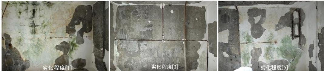
写真－6 48号棟室内天井の劣化程度例
