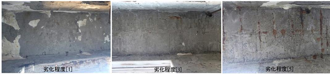
写真－7 48号棟廊下天井の劣化程度例
