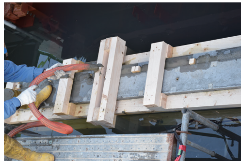
(a) 充填中の状況
