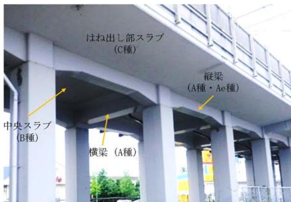
図-1 維持管理標準による既設表面保護工<sup>1)</sup>
