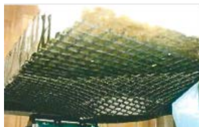
写真-3 押抜き試験後の状況
