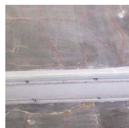
写真-10 塗膜撤去状況
