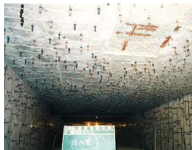
写真-7 ひび割れ注入状況
