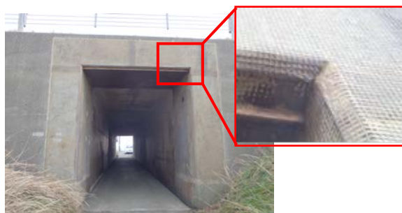
写真-4 剥落防止工施工後の状況 (施工後 5 年)
