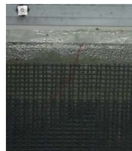
写真-12 バサルトネット 施工後
