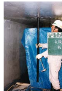
写真-8 水抜き設置
