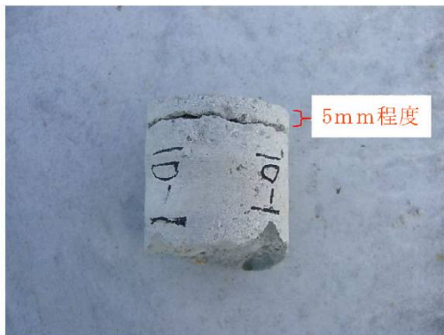
写真-8 No.10スラブのコア抜き
