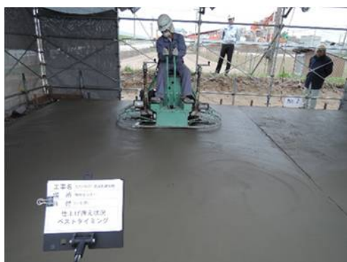
写真－3 騎乗式トロウェルによる仕上げ
