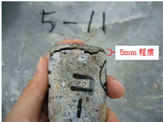
写真-6 肌分かれ部のコア抜き採取
