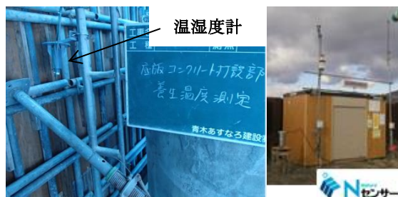
写真-2 養生の環境温湿度測定
