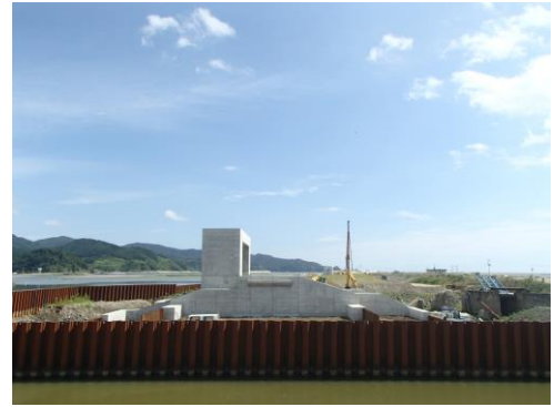
(b) 竣工時の水門の全景
