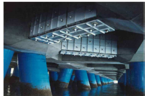
写真-1 亜鉛シート工法の設置状況（1988 年 8 月）
