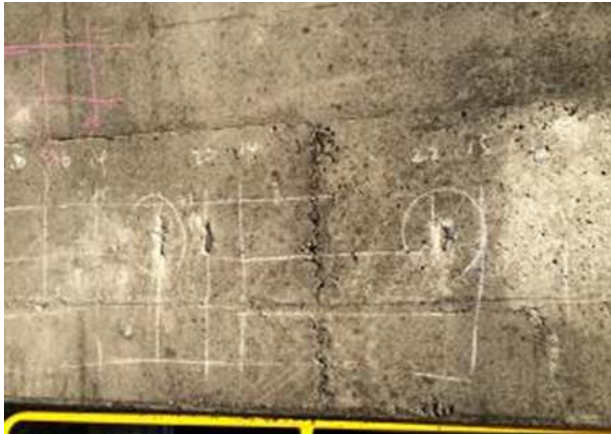
写真-1 高架橋試験箇所
