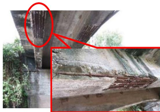
写真-1 被りコンクリート剥落や鉄筋露出の損傷状況
