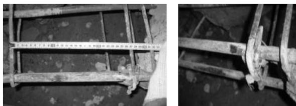
帯筋間隔 帯筋端部
