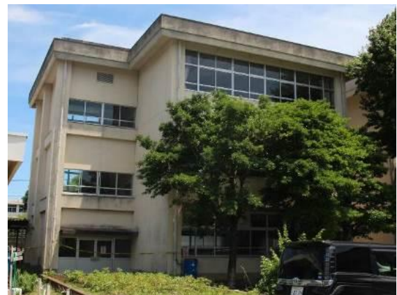
写真-1 対象建物南側外観
