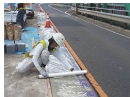
(6)封かん養生（完成）
