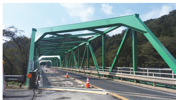
図-9 施工場所の全景
