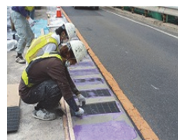
(4)エポキシ樹脂1塗布とCFSS接着
