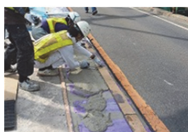
(5)保護モルタルの施工
