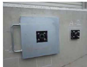
(d)反力板の設置
