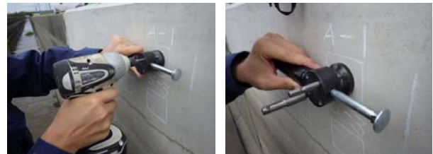
(a)垂直穿孔治具による削孔
