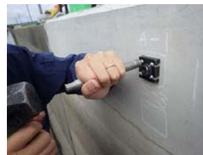
(b)アンカーの打込み
