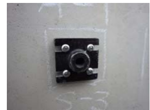
(c)アンカー治具の固定
