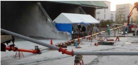
写真－１ 配管経路の全景
