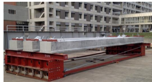
写真－2 PC 桁の暴露状況
