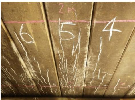
写真-1 橋梁 1 下面に見られる PC 桁のひび割れ
