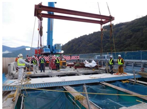
写真-2 日野川橋梁の床版更新工事
