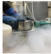
写真-5 液体窒素を吹き付けている状況
