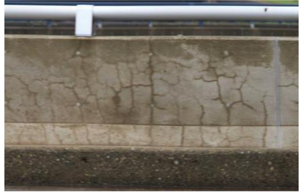
図-4 2016年8月の現地調査における壁高欄部のひび割れ性状(山側)
