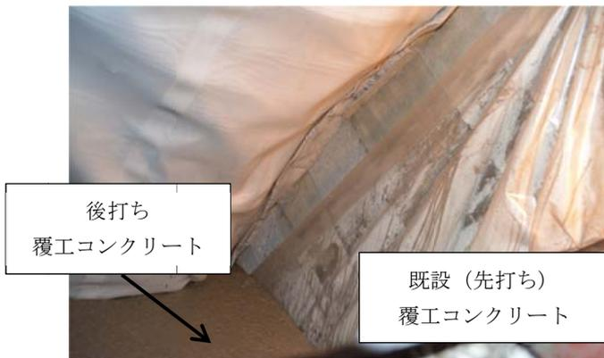
写真-2 ビニールシートによる対策の現場施工状況 (打込み状況)
