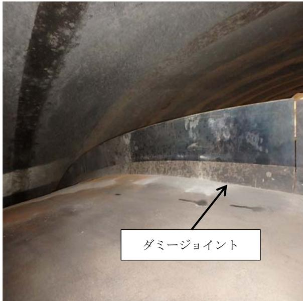
写真-5 鋼板設置状況（セントル内部より）
