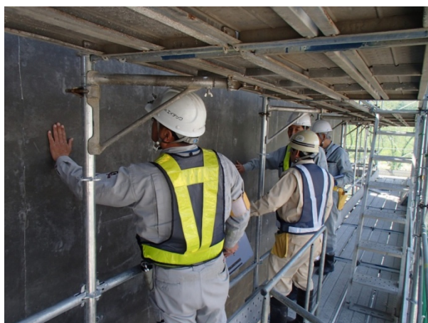
写真-3 表層目視評価状況
