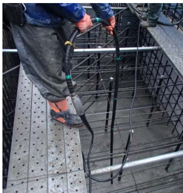
写真-2 バイブレータマーキング状況
