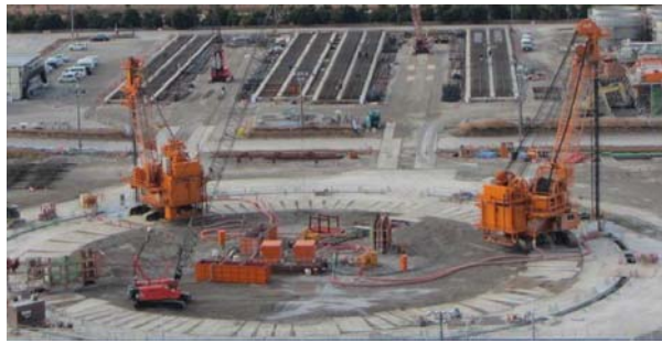
写真－１ 地中連続壁掘削状況全景
