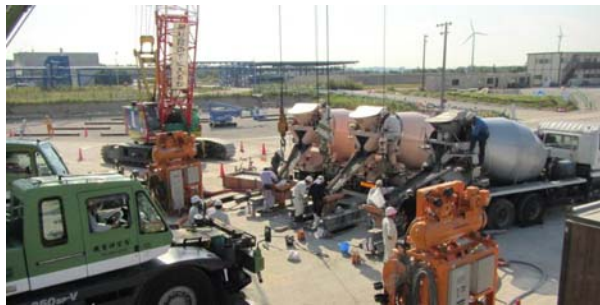
写真－２ 地中連続壁コンクリートの施工状況
