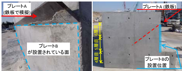
写真－８ 試験施工の用いたモデルの脱型後の外観
