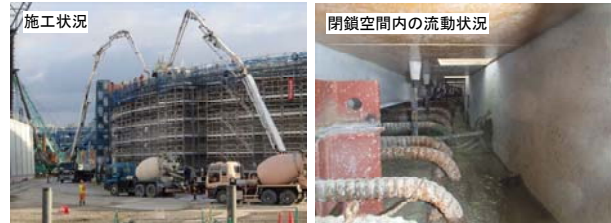
写真－９ 側壁 7 ロットの施工状況
