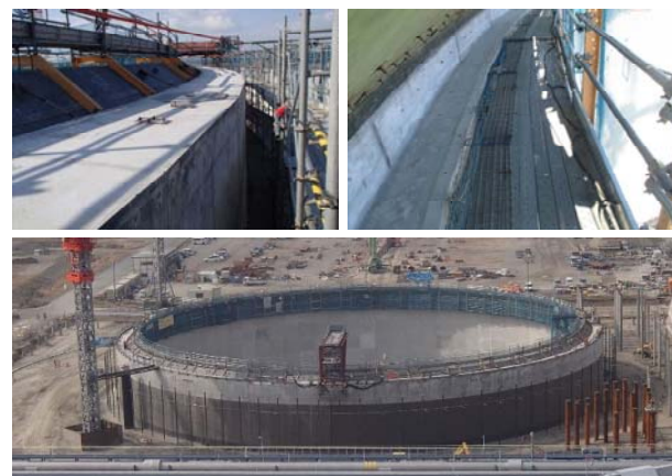
写真－１０ 側壁 7 ロットの施工完了後の外観
