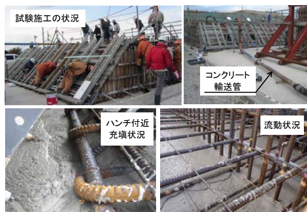
写真-2 コンクリートの流動・充填状況（試験施工）
