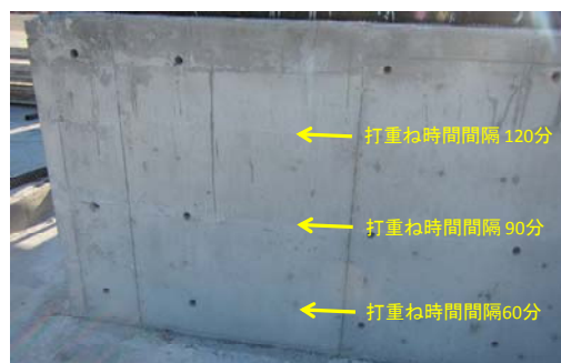
写真-4 脱型後の外観（打重ね時間間隔の確認）
