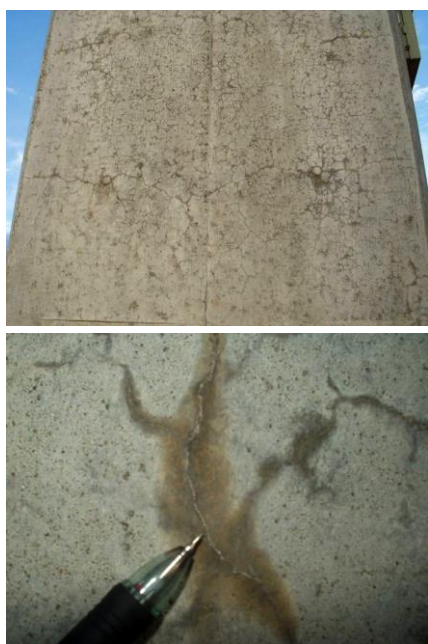
写真-11 チャートによる被害事例（中部地方）
