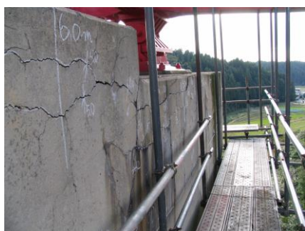
写真-5 火山岩類による被害事例（北陸地方）
