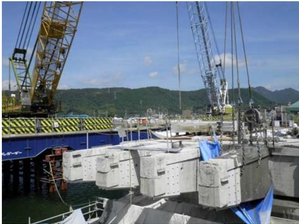
図-2 ワイヤソーによる主桁切断と吊り上げ状況
