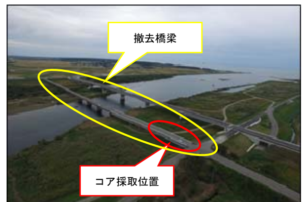
写真-1 試験橋梁・全景およびコア採取位置
