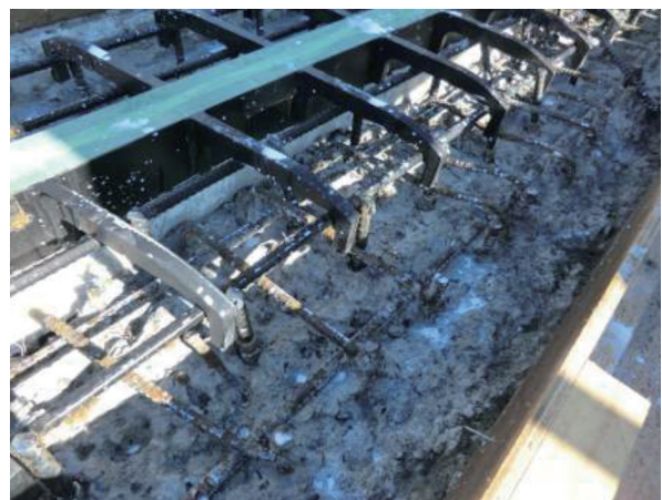
写真-1: ジョイント交換の状況
