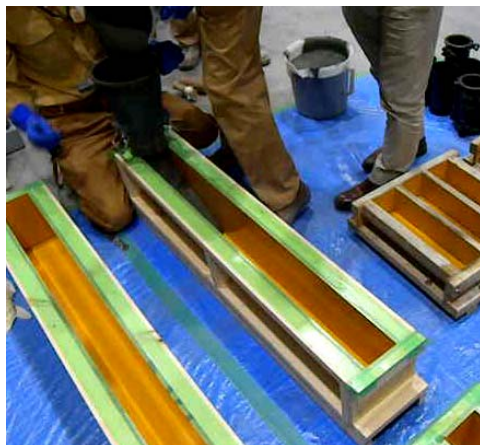
写真-1 100×200×1200 試験体 打込み状況
