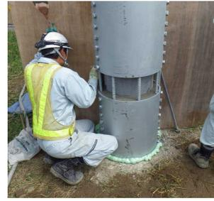
写真-5 上・下段部モルタル打設
