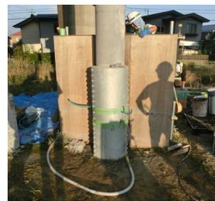
写真-9 塑性ヒンジ部モルタル打設
