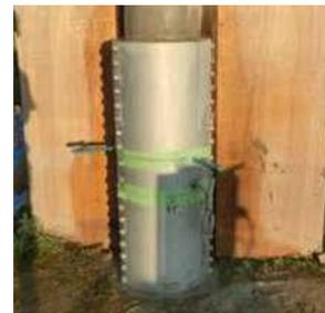
写真-8 塑性ヒンジ鋼管設置
