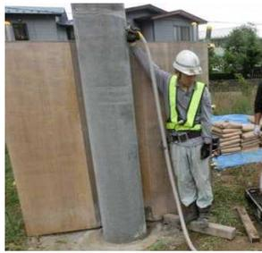
写真-3 内部充填モルタル
