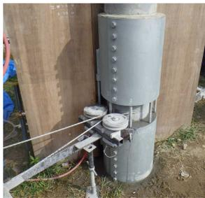
写真-7 PC 鋼線切断(拡大)
