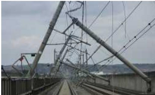
写真-1 被災した PC 電化柱
