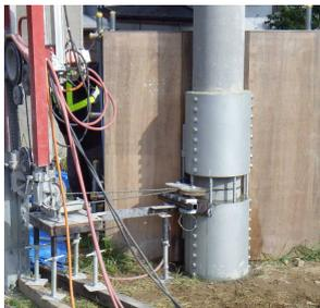
写真-6 PC 鋼線切断
