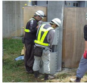
写真-4 鋼管ユニット設置
