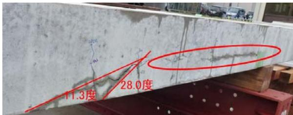
写真-1 せん断破壊面の角度
