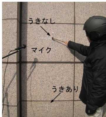
図-11 打音法による外壁タイルうき検知試験
